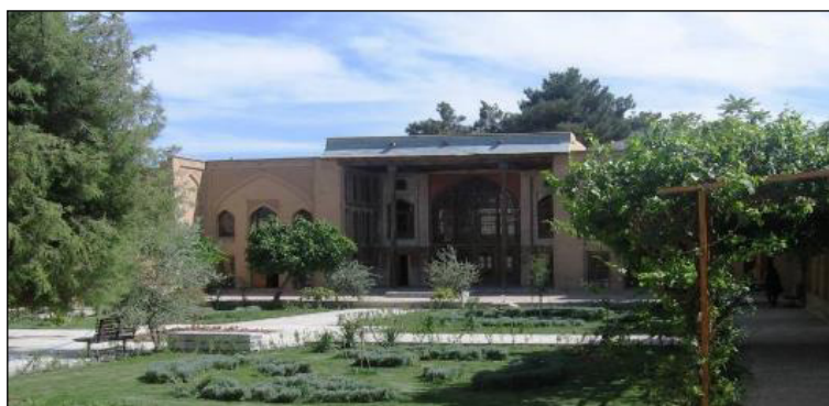
شکل ۲. نمایی از ساختمان‌های مرکزی و حیاط خانه تاریخی سوکیاس ۱ (تاریخ عکس تابستان ۱۳۸۷)
