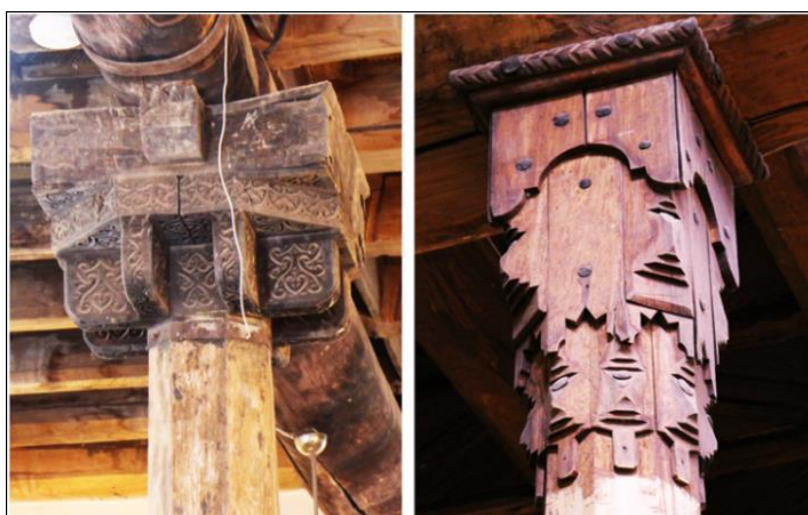
شکل ۷: سرستون‌های چوبی مسجد جامع ایبانه
