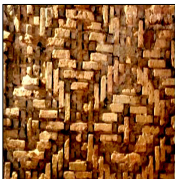
شکل ۲۰. چیدمان آجر با طرح گل‌انداز در تزئینات بیرونی گنبد سلطانیه (اکبریان، ۱۳۹۳: ۵۹)
