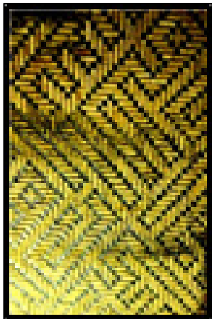
شکل ۲۲. ترکیب آجر و کاشی‌های نگینی به صورت معقلی در گنبد سلطانیه (اکبریان، ۱۳۹۳: ۵۹)
