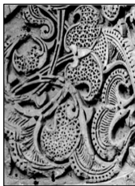
شکل ۴۴. بخشی از جزئیات گچ‌بری مشبک با طرح‌های آژده‌کاری بادبزی طاق‌نمای پایین محراب هفتشویه (موحدی، ۱۴۰۰: ۱۴۲)
