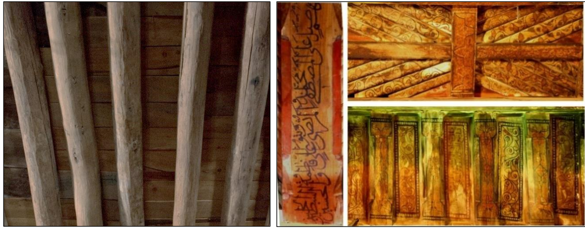
شکل ۱۸: توفال کوبی، به همراه نقاشی و خوشنویسی بر روی سقف مسجد جامع ایبانه (راست) به صورت ساده و بدون آرایه مسجد اولو سیوریحصار (Anonim, 2022, p. 46)
