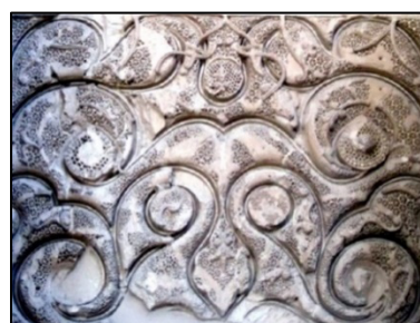
اسلیمی‌های گچی با روش مشبک و طرح‌های حلزونی و مرواریدی در طاق‌نمای جنوبی دیوار شرقی مقبره‌ی پیر بکران (شایانی مفرد، ۱۳۹۰: ۱۶۵)
