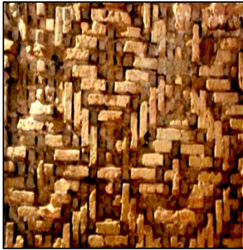
شکل ۲۰. چیدمان آجر با طرح گل‌انداز در تزئینات بیرونی گنبد سلطانیه (اکبریان، ۱۳۹۳: ۵۹)
